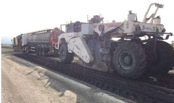
*Figura 74: Mezzi contenenti cemento, emulsione ed acqua che formano il cosiddetto "treno".*
