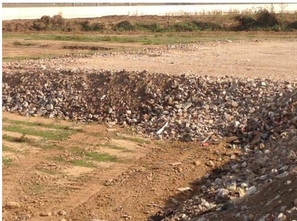
*Figura 75: AR depositati in cantiere.*
