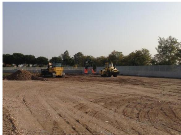
*Figura 76: Bulldozer e rullo compressore all'opera.*
