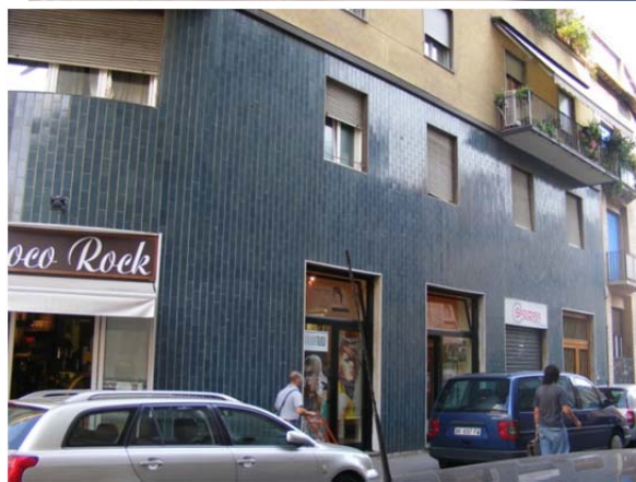
2. Il rivestimento ceramico isolato termicamente.
