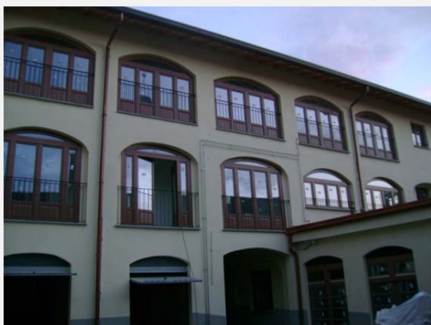
Prospetto interno dopo i lavori.
