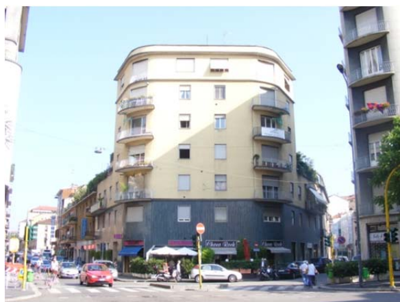
1. Vista generale dopo i lavori.
